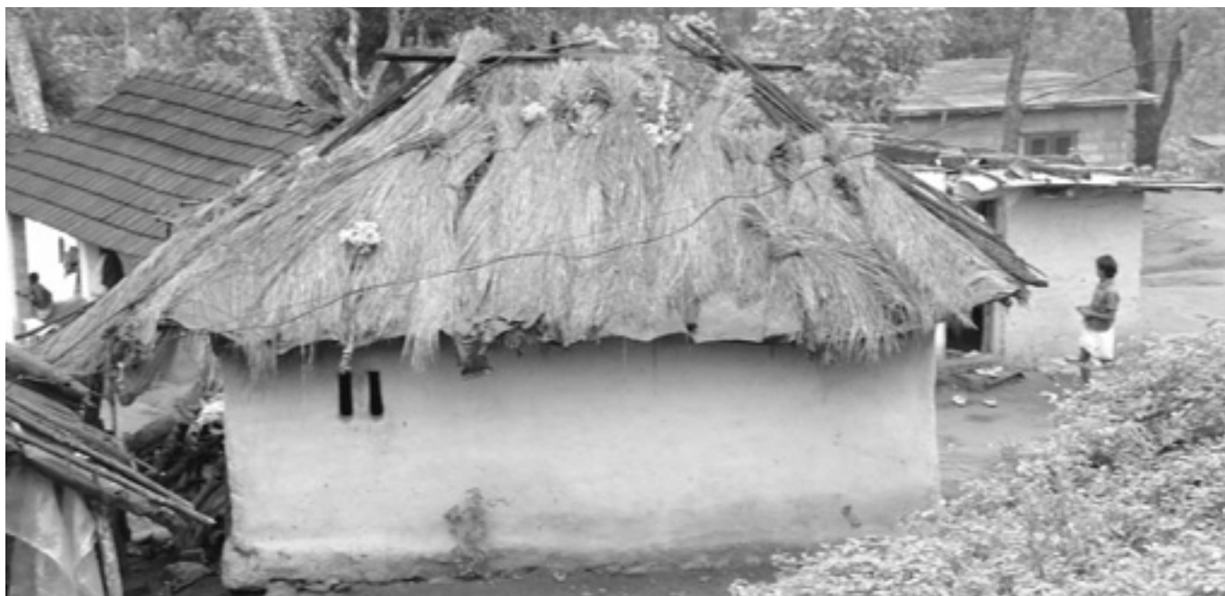
Toitures en plastique agricole recouvertes de joncs.
