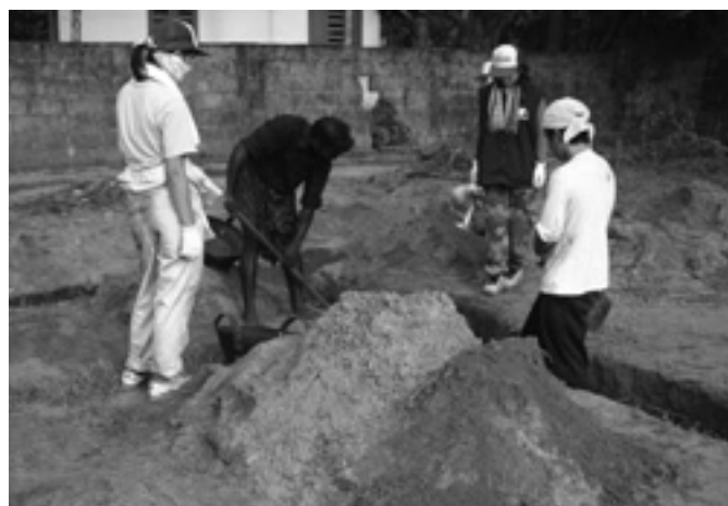
... en werken aan de fundering*
