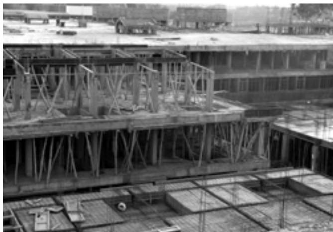
De bouw in volle gang
