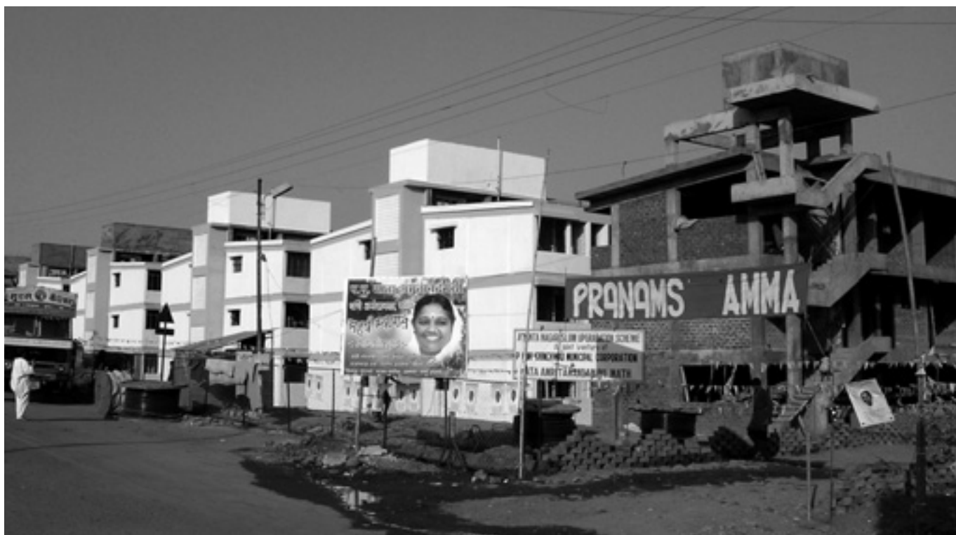
Dankbetuigingen aan Amma wegens de voortgang in de bouw
