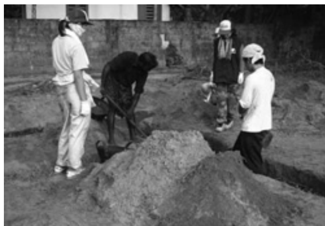
... et travailler aux fondations *
