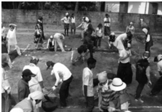
Travailler aux fondations ... *
