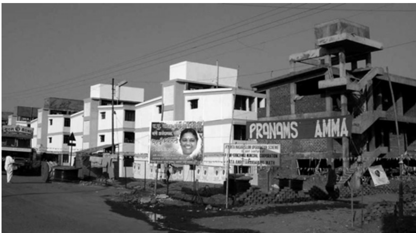
Remerciements à Amma pour la progression du chantier
