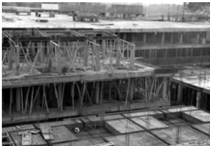
Le chantier bourdonne d'activités
