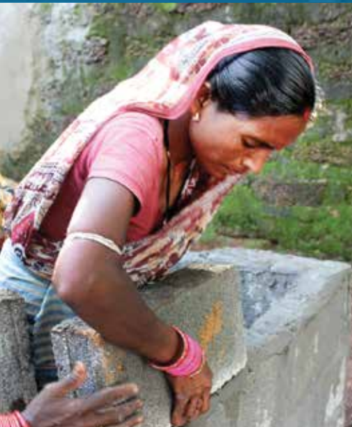
Construction de toilettes et source de revenus
