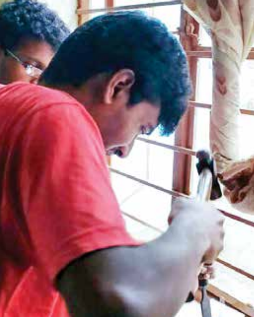
Électrification de villages isolés
